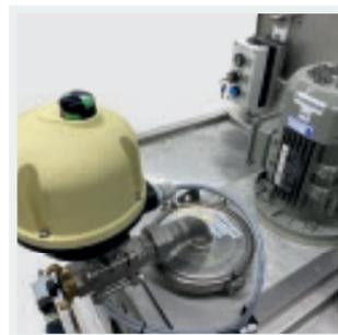
Schmutzwassertank mit integriertem Zulaufgrobfilter (<5 mm) sowie Rührvorrichtung
