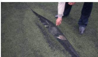
Ein Spielfeld mit offenen Nähten ist gefährlich und kann zu Verletzungen führen
