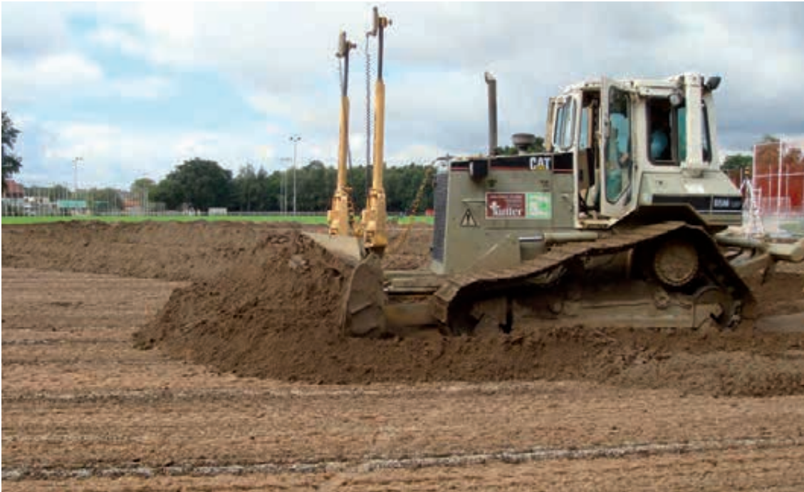
Abb. 34: Auftrag der Rasentragschicht auf einen Baugrund mit Dränschlitz-Entwässerung (Aufbaubeispiel 3)
