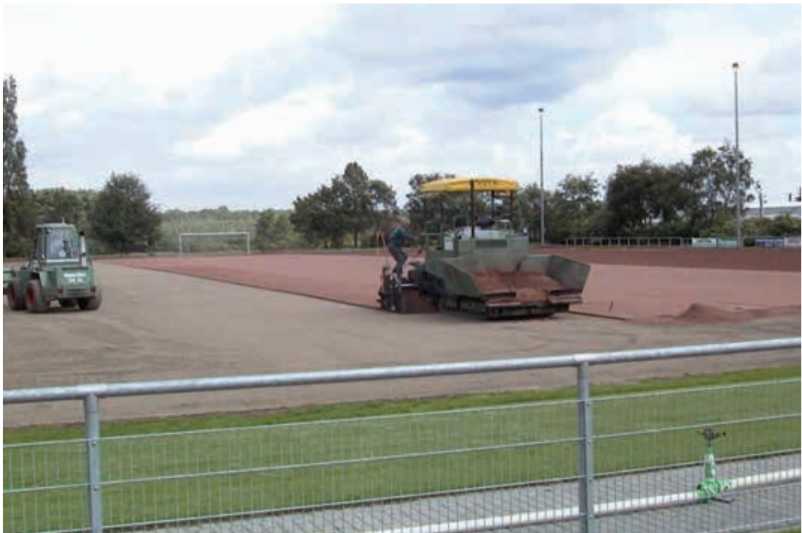
Abb. 76: Schottertragschicht während des Einbaus
