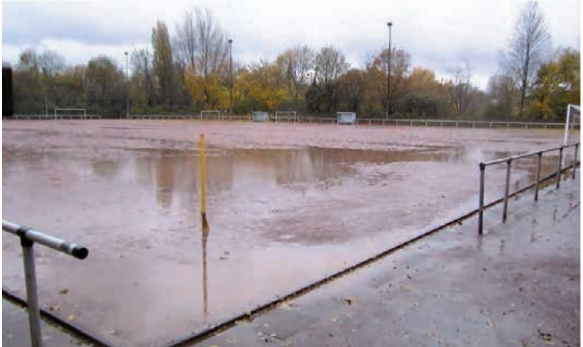
Abb. 90: Völlig unzureichende Wasserdurchlässigkeit eines Tennensbelages
