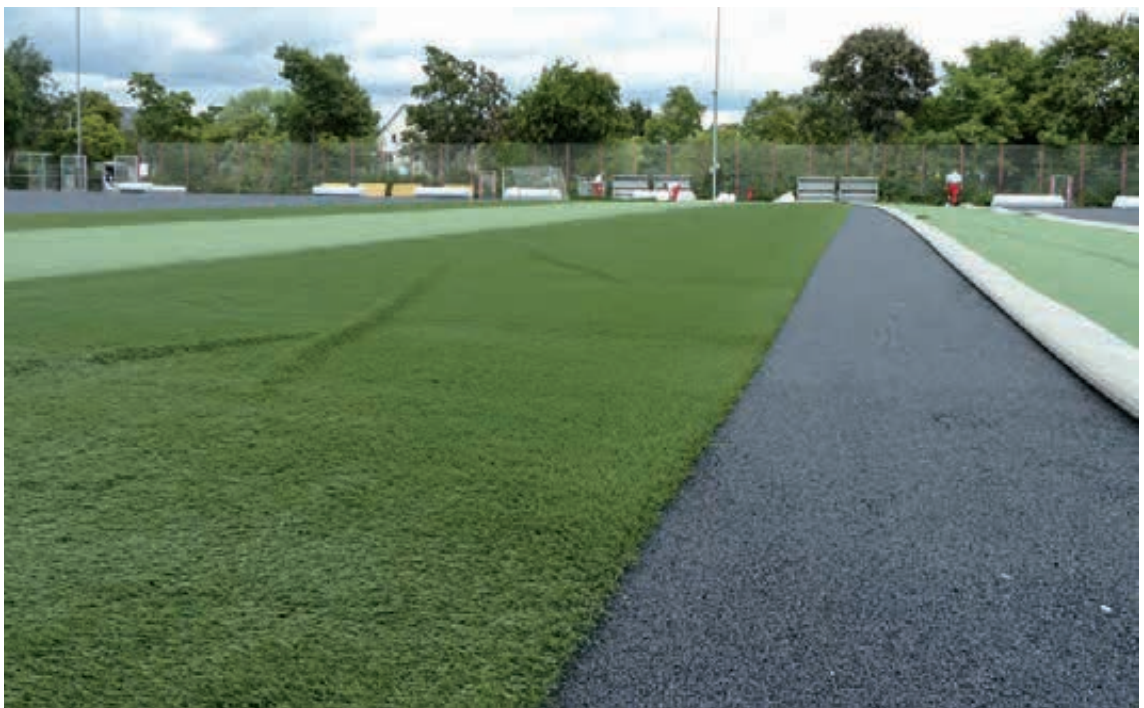
Abb. 120: Verlegung von Rasenbahnen
