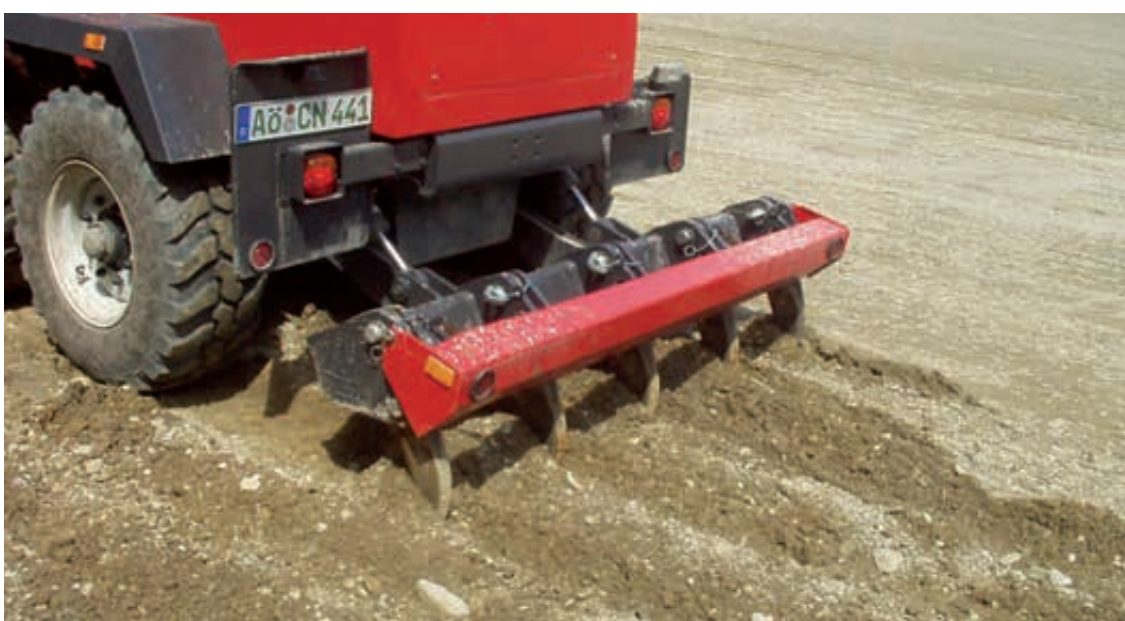
Abb.30: Baugrundlockerung nach Herstellen des Erdplanums
