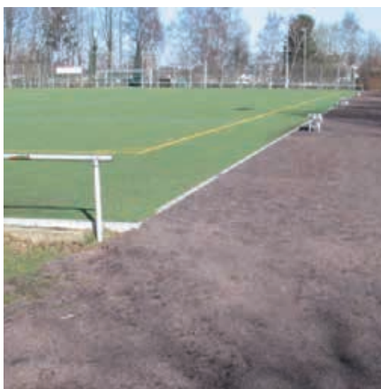
Abb. 126: Ungeeignete Belagskombination (Kunststoffrasen/Tenne)
