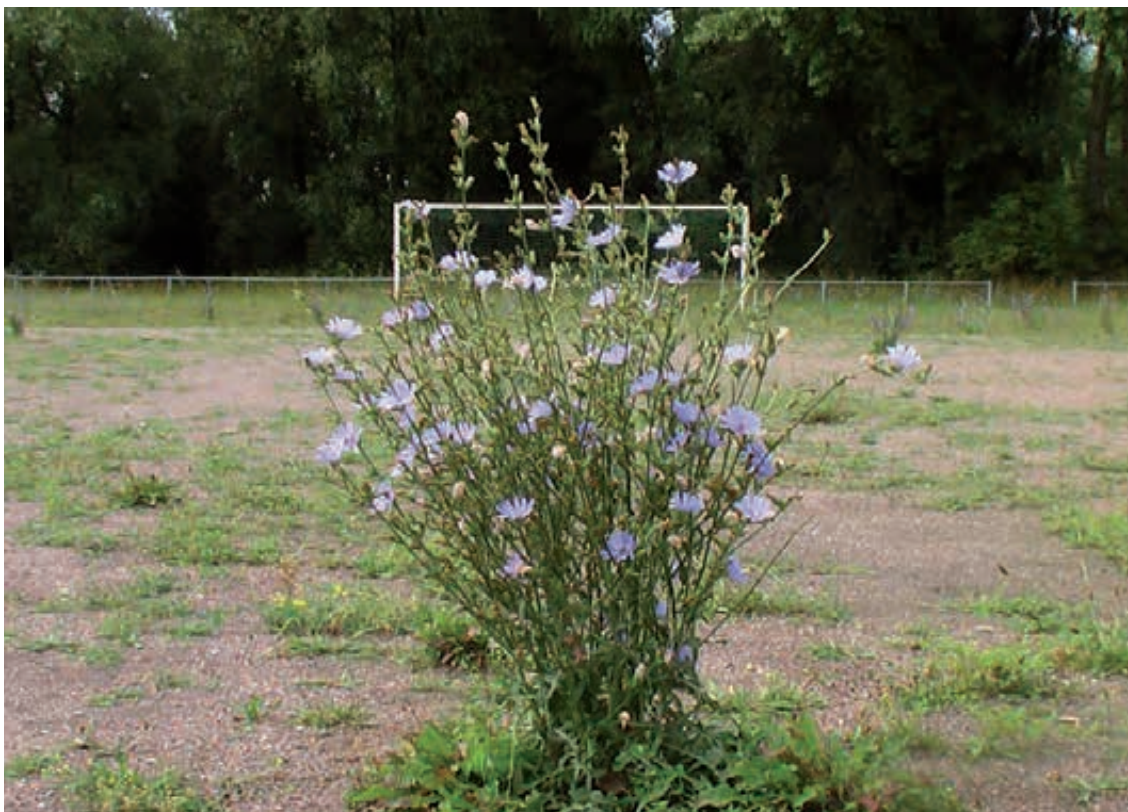
Abb. 83: Vernachlässigte Pflege bringt unerwünschten Pflanzenbewuchs, mechanische Maßnahmen schaden oft dem Belag.
