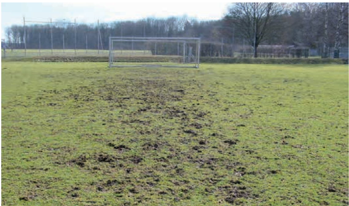
Abb. 52: Oberflächennahe Verdichtung des Rasenbodens mit Wasserrückstau und Trittspuren auf einem herkömmlichen Rasenplatz im Spätherbst
