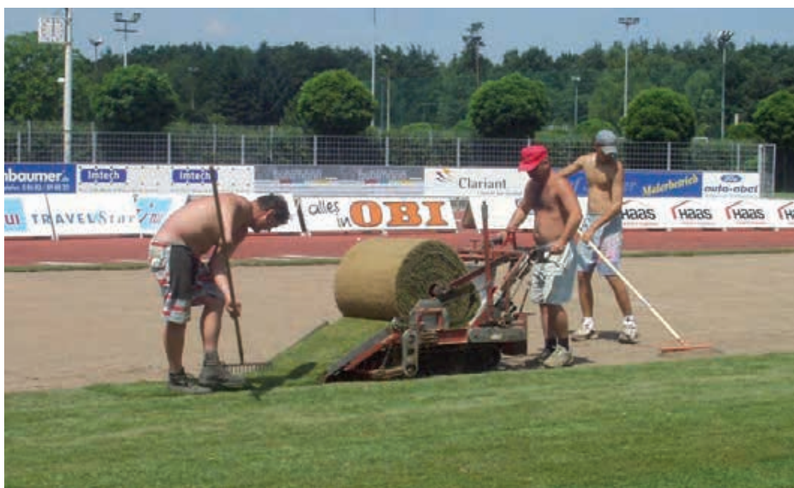
Abb. 36: Verlegen von Fertiggrasen, unmittelbar nach Aufrauen des Planums der Rasentragschicht
