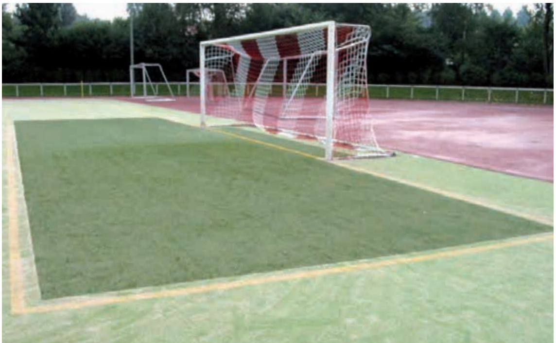
Abb. 132: Kunststoffrasen im Torraum erneuert
