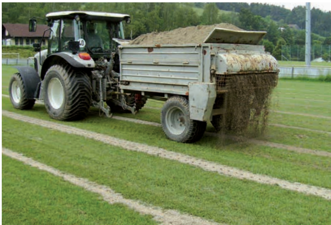
Abb. 64: Besanden zum Abschleppen der mit Dränschlitzern versehenen Rasenfläche als Abschluss der Renovationsmaßnahmen
