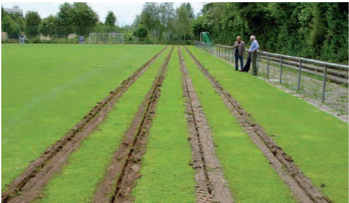
Abb. 63: Gefräste schmale Dränschlitzte ohne Synchronaufnahme des anfallenden Bodens. Der sandige Boden wird nach dem Verfüllen der Dränschlitzte verschleppt.
