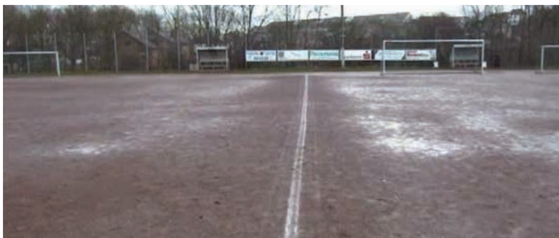
Abb. 80: Markierungslinien, erhöht
