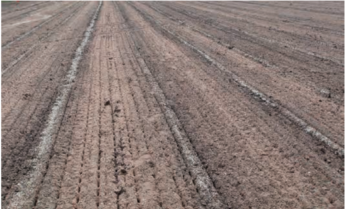
Abb. 31: Mit Kies verfüllte Dränschlitze und Intrasollockerung des Baugrundes
