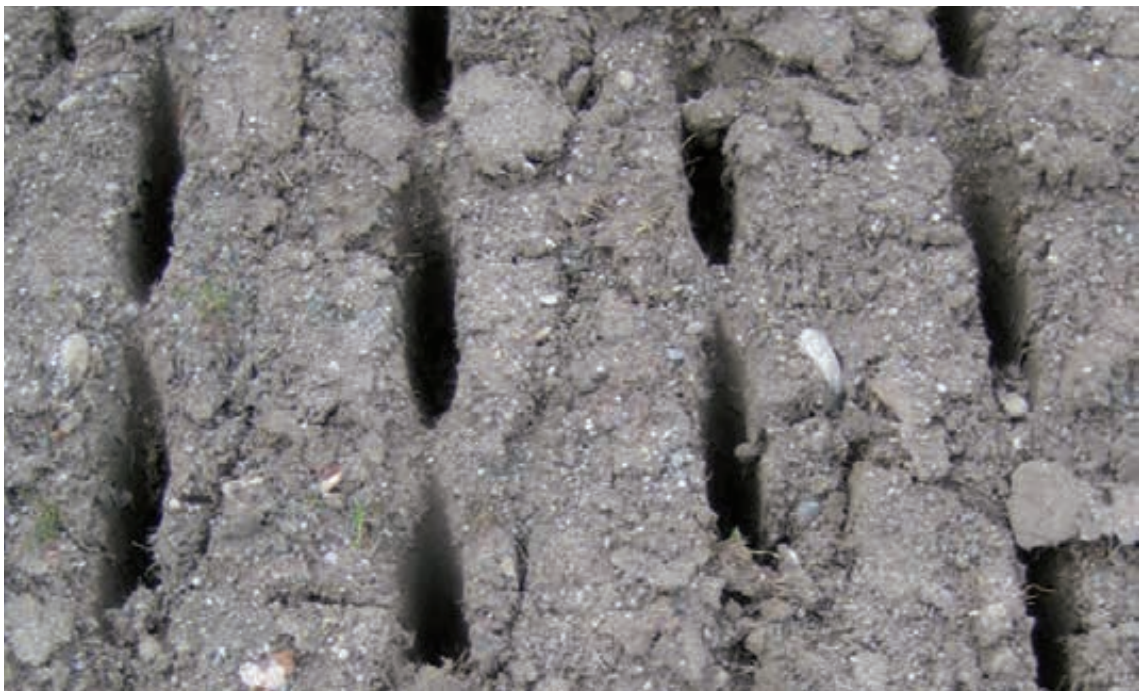
Abb. 32: Noch nicht mit Sand verfüllte Intrasolschlitze im Baugrund
