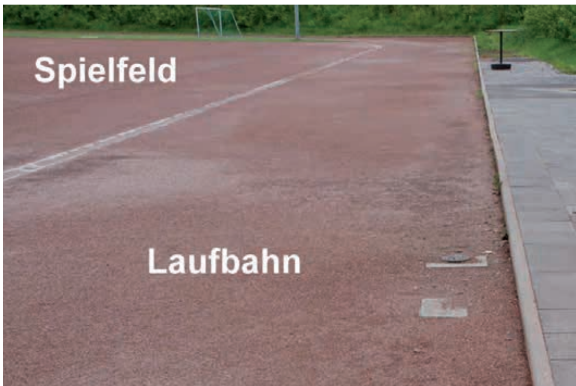
Abb. 12: Schieberkappe und Ventilschacht im hindernisfreien Bereich einer Laufbahn
