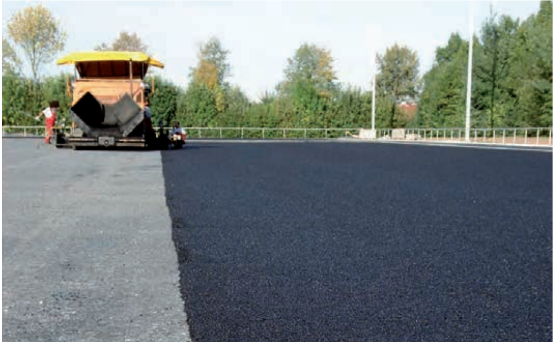
Abb. 119: Installation von elastischen Schichten
