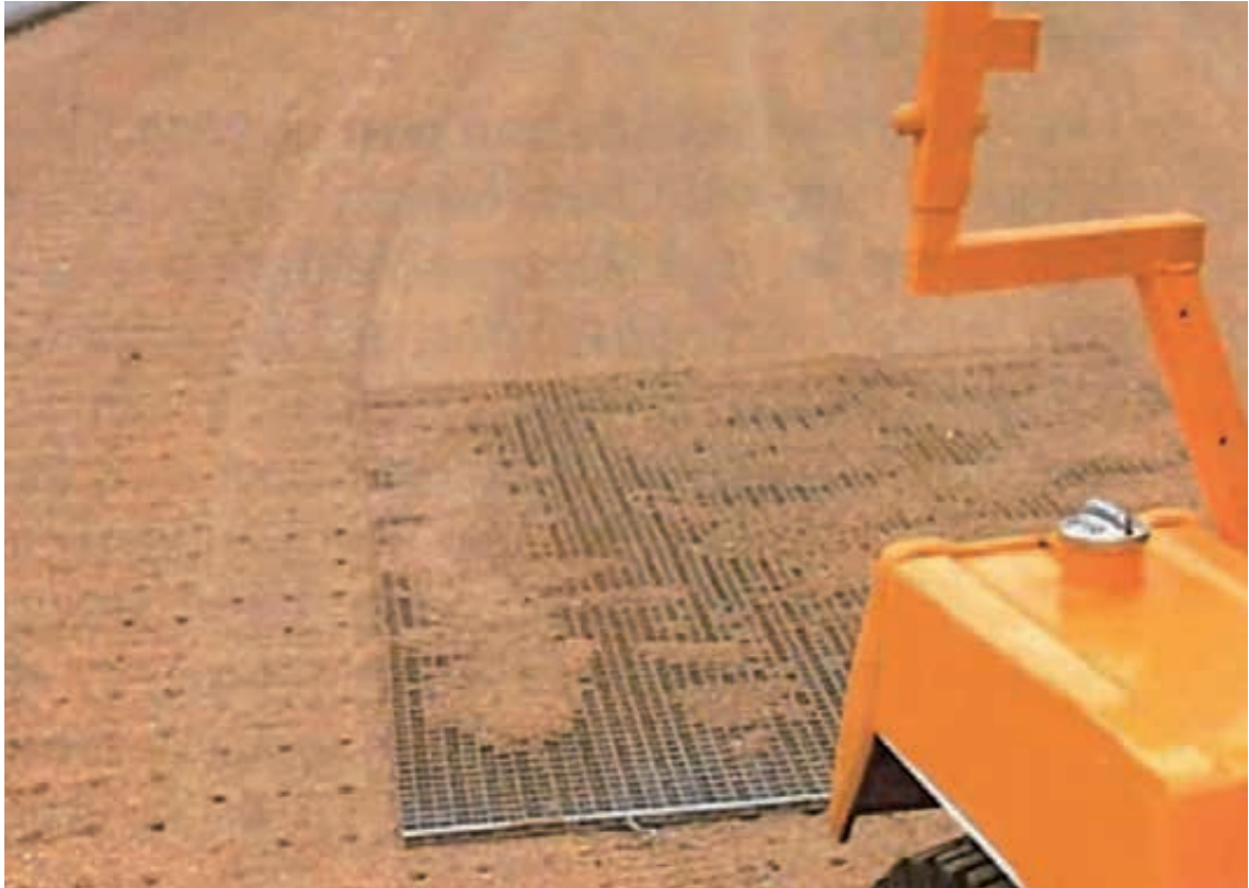
Abb. 89: Einschleppen des Stützkorns in die Lochkanäle
