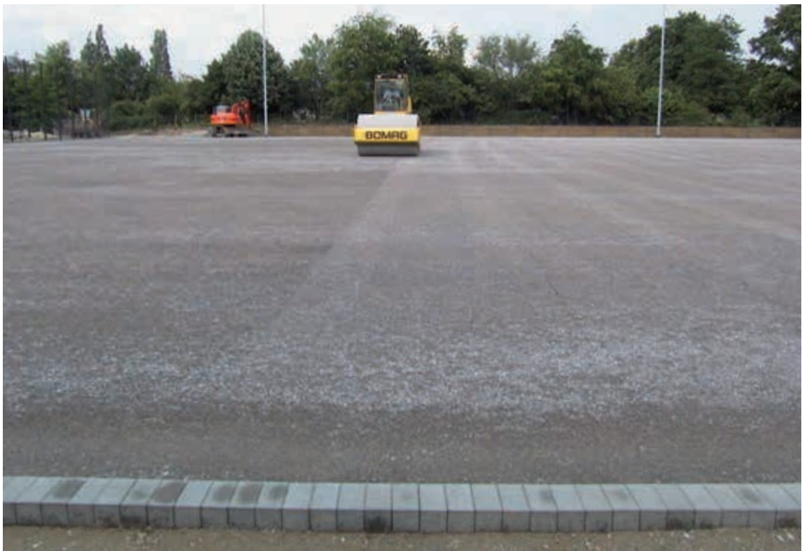
Abb. 74: Schottertragschicht während des Einbaus
