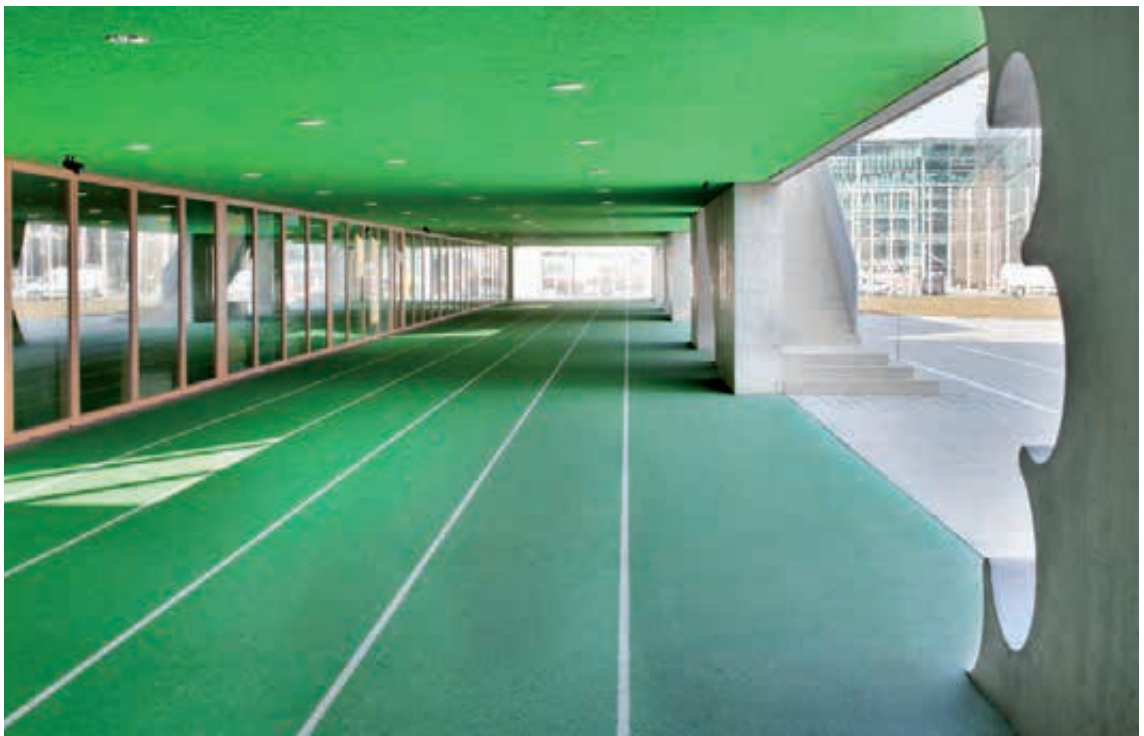
Abb. 112: Multifunktionsfläche, Schüttbeschichteter Belag Typ B
