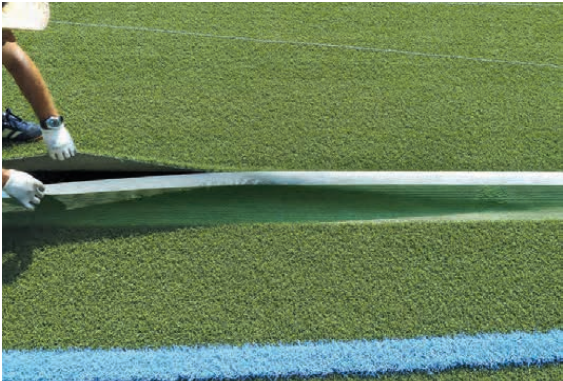
Abb. 121: Installation der Markierungslinien
