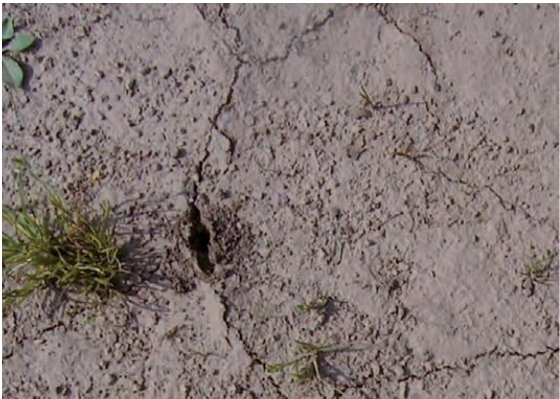
Abb. 87: Feinteilablagerungen auf einer Tennenfläche
