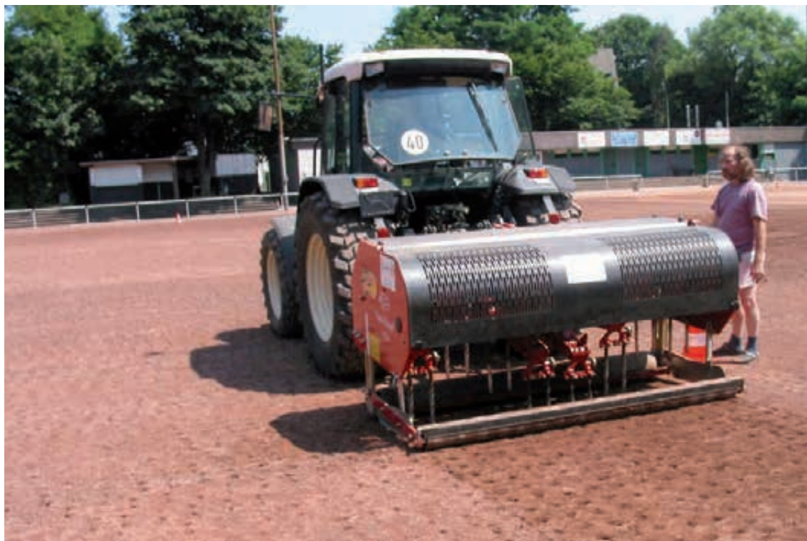
Abb. 88: Lochen eines undurchlässigen Tennenbelags und Perforationslöcher
