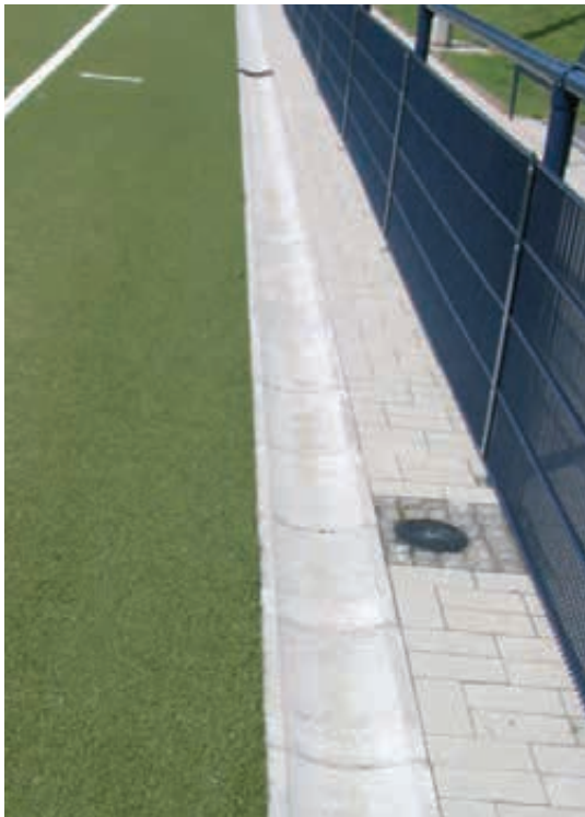
Abb. 24 und 25: Anordnung der Teilkreisregner im hindernisfreien Raum bei Kunststoffrasen- und Tennenflächen
