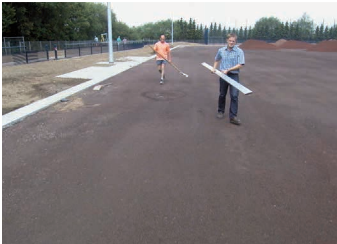
Abb. 75: Überprüfung der dynamischen Schicht vor dem Einbau des Tennisbelages
