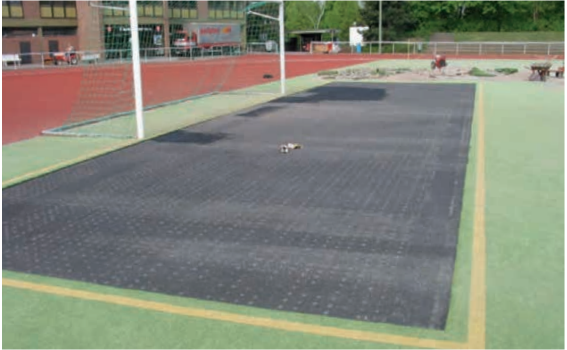
Abb. 131: Kunststoffrasen ausgeschnitten und ET-Schicht überarbeitet
