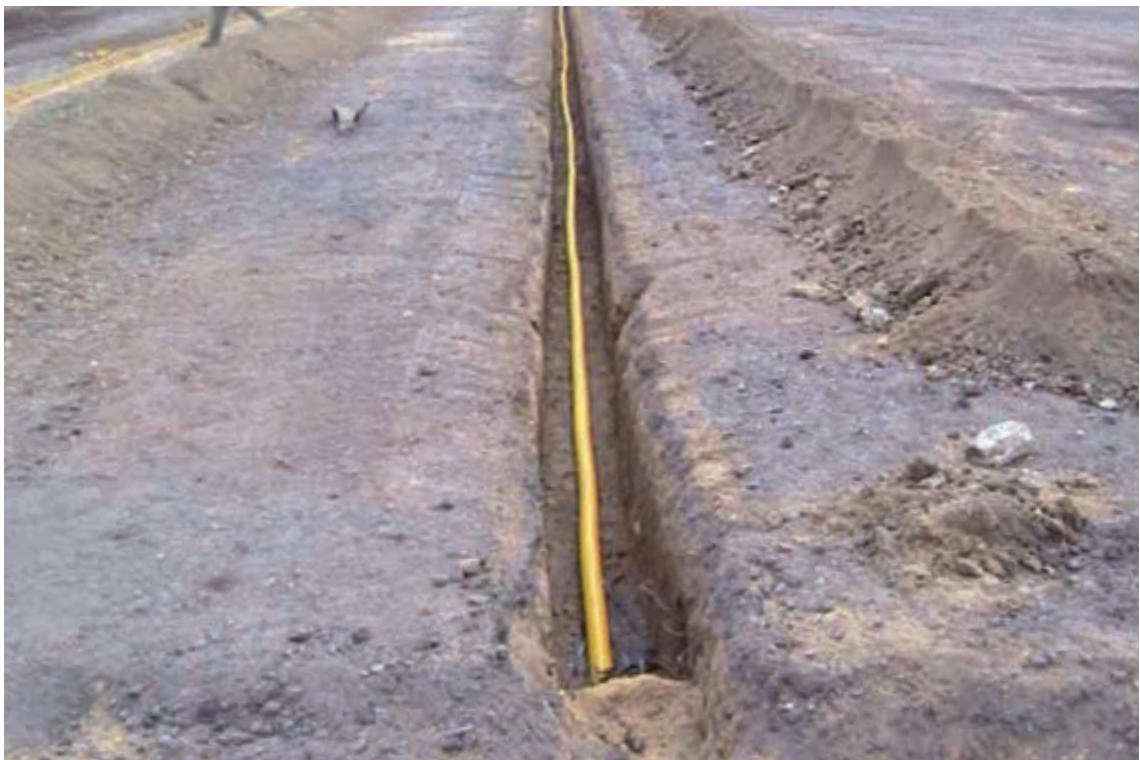
Abb. 127: Dränstrang mit Dränleitung
