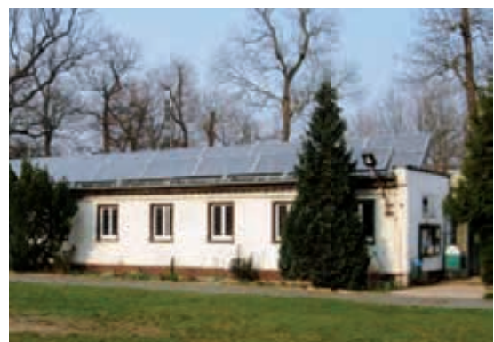
Abb. 1: Funktionsgebäude mit Solardach, Nachrüstung
